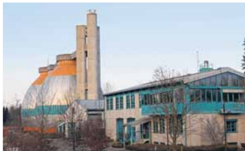
Auf den Betriebsgebäuden des Gruppenklärwerks wird kommandes Jahr eine Solarstrom-Anlage installiert. Foto: Ralf Lienert
